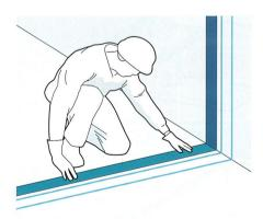
En el caso de paredes separadoras con bandas elásticas perimetrales, antes de levantar la fábrica deben colocarse las bandas elásticas:
